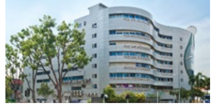
14 1 Bukit Batok Street 22
